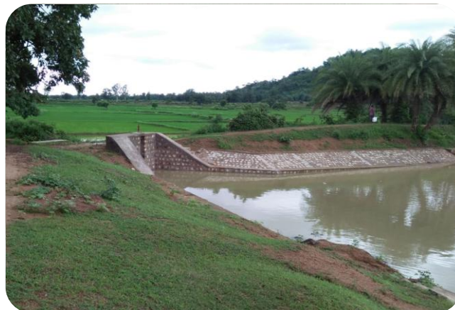
स्लूज गेट निर्माण
